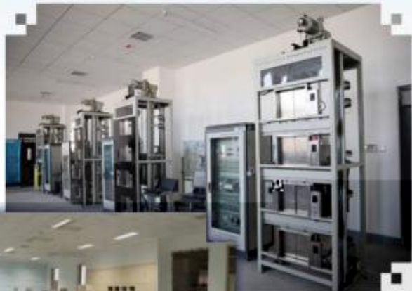
智能电梯安装调试 维护训练场所
